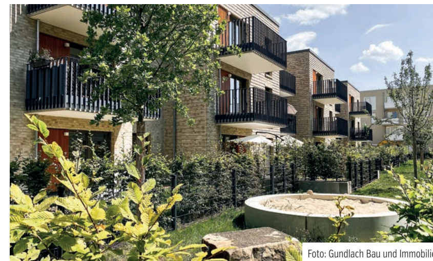
Foto: Gundlach Bau und Immobilien
