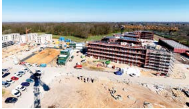
Abb. 33: Baustelle Herzkamp im November 2021 [Foto: Alexander Schlichter]
